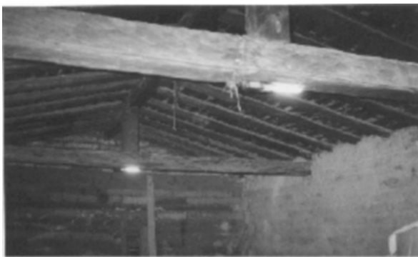
SISTEMA FOTOVOLTAICO FUNCIONANDO
