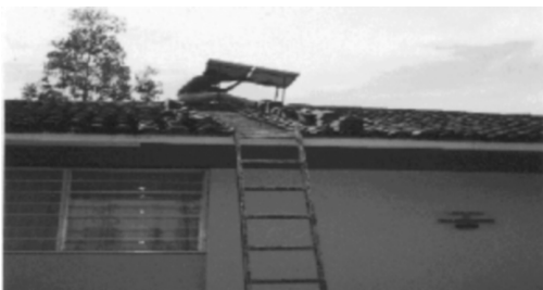
INSTALACIÓN DE MÓDULOS SOLARES PARA REALIZAR PRUEBAS
