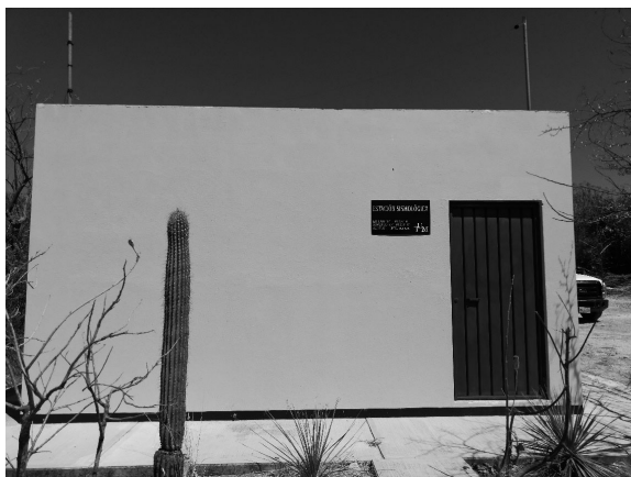
Figura 1. Inmueble donde se ubica la Estación Sismológica UTM.
